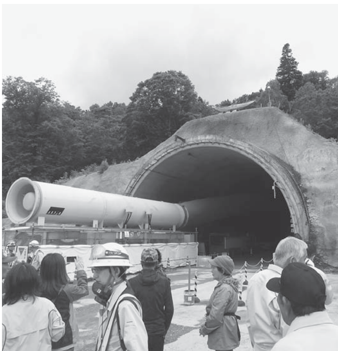
6月27日 音中トンネル(仮称)掘削現場の様子
