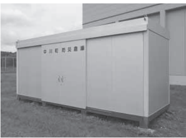
防災倉庫 (トレーニングセンター裏)
